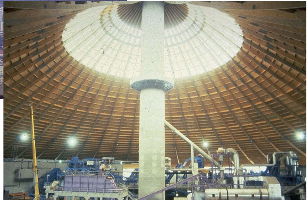
Halle de recyclage de Vienne Architecte: L. M. Lang Ingénieur: Natterer und Dittrich plannungsgesellschaft
